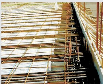
I benefici di delle pignatte in **EPS** sono la riduzione del peso del solaio.
